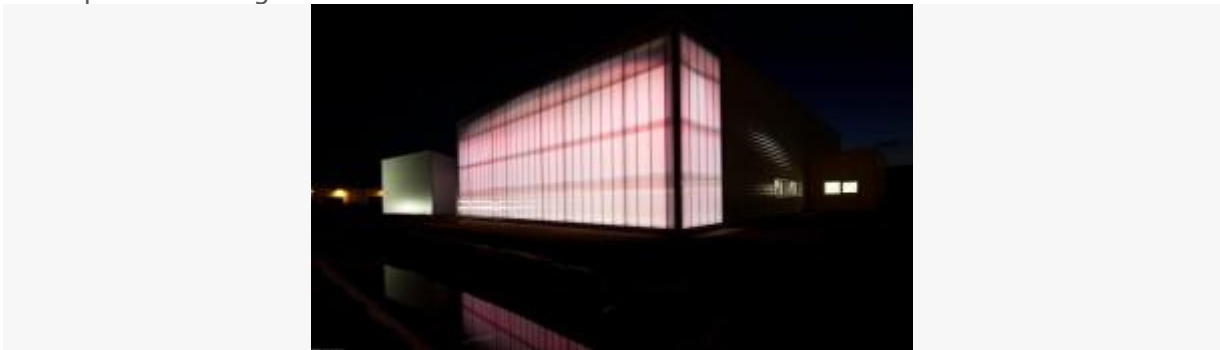
Eclairage nocturne de la façade de l'atelier, translucide pour apporter en journée, le plus de lumière naturelle possible.
